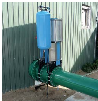
Immissione diretta del dosatore di sostanze solide nel fermentatore
