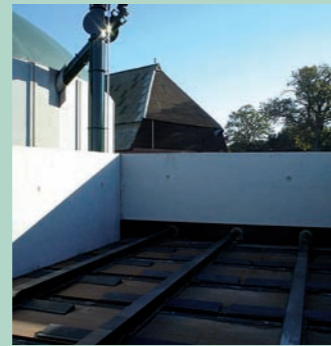
Schuifbodem in combinatie met ontvangstcontainer in betonuitvoering
