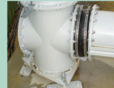
Aankoppeling van de verticale transporteurs bij een weegstelsel
