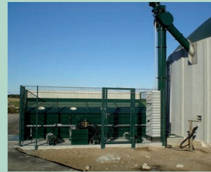
Schuifbodem in combinatie met pre-fab betonnen ontvangstcontainer
